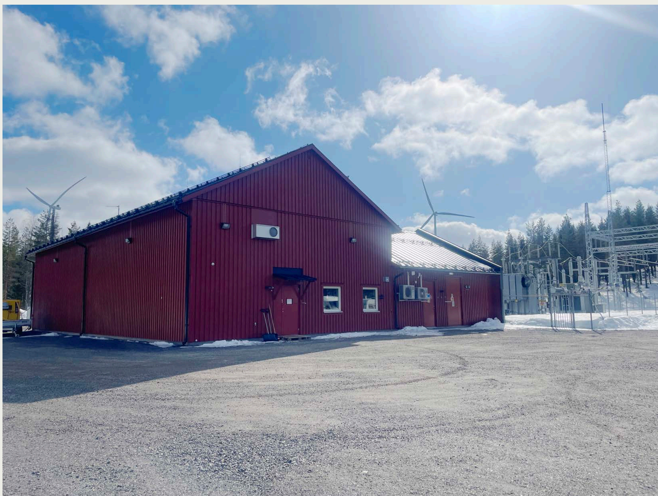
Service- och driftcentral Fäbodliden
