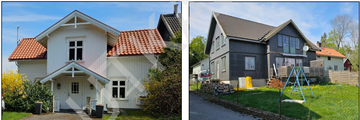
Figur 8-11. SEFRAK-bygninger, Brensrød (alle på bildet unntatt rødt uthus ytterst til høyre). Alle meldepliktige (pre 1850).
