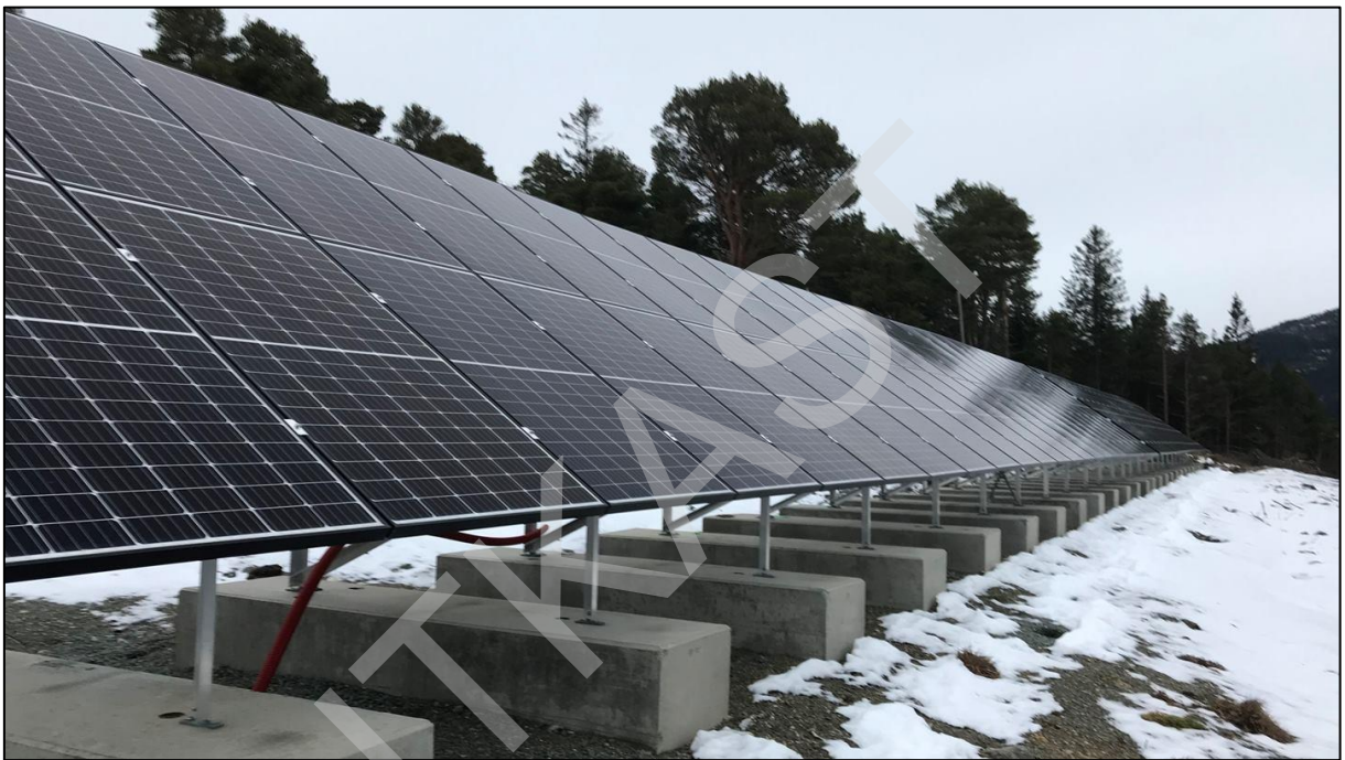
Figur 6-21. Eksempelvis solcellepaneler når sett fra nærområde. Panelene vil være dominerende. Kilde: NVE, 2020. Eksempelet i bildet bruker betong som gravitasjonsfundament.
