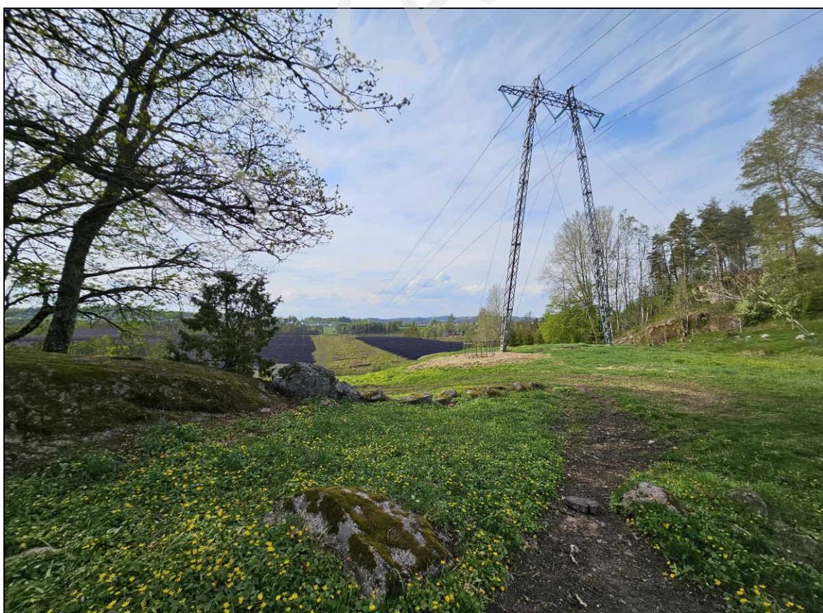
Figur 6-23. Utsikt fra kulturminne "Aker" ved Løkeberg øst for tiltaksområdet der terrenget heller ned mot Akersmyra. Landskapsbildet er preget av andre inngrep, som kraftledningstraseen. Utsikt mot Sem. Før utbygging (over) og etter utbygging (under).
