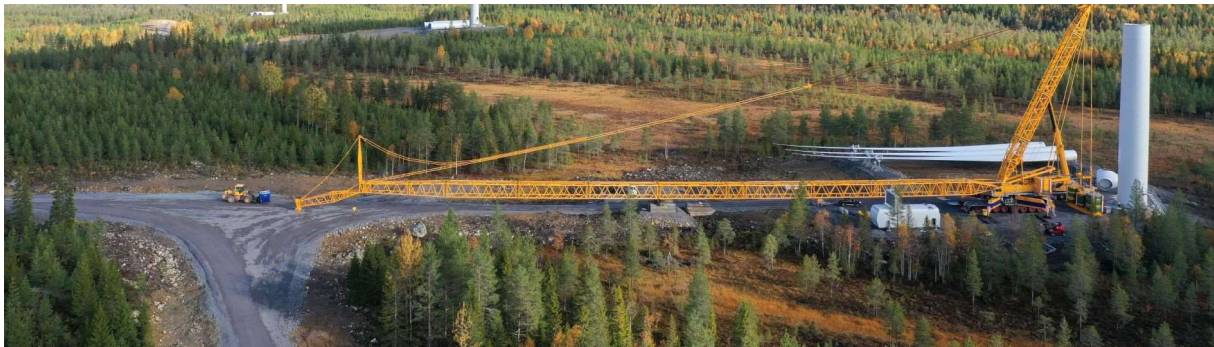
Figur 11. Väg fram till vindkraftverk i en av Fred Olsens vindkraftsparker. Foto: Fred. Olsen Renewables AB.
