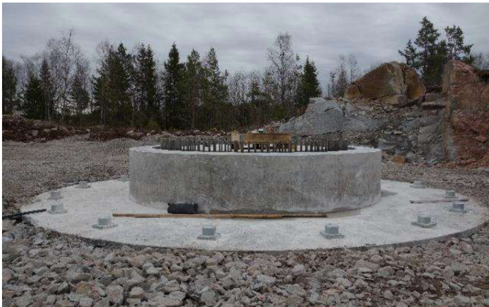
Figur 8. Bergförankrat fundament i en av Fred Olsens vindparker. Foto: Fred. Olsen Renewables AB.
