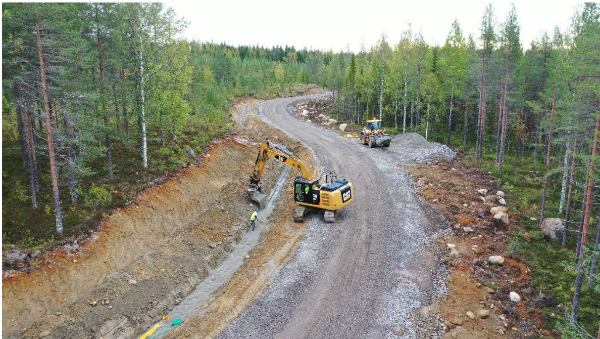
Figur 12. Kabelgrav med kabel och kommunikationsnät intill väg. Foto: Fred. Olsen Renewables AB.
